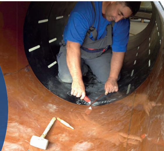
Innenbeschichtung einer Trommel
